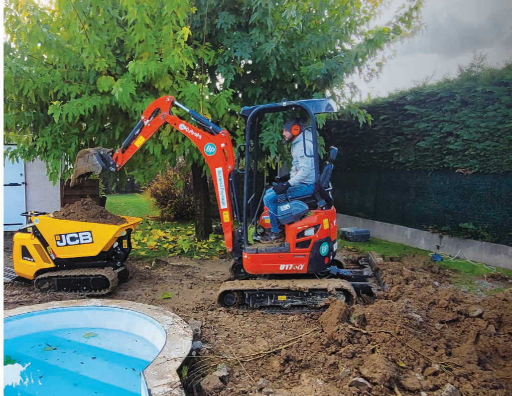
Transport de terre par brouette à chenille avec minipelle
