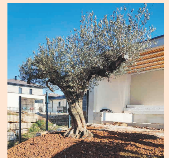
Préparation du sol
