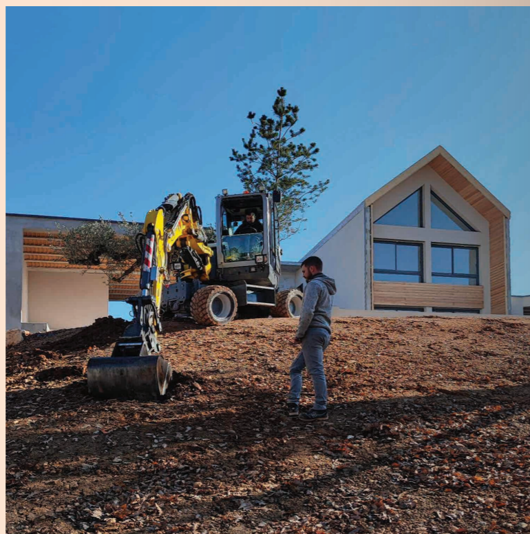
Mise en place du trou de plantation pour grand pin sylvestre
