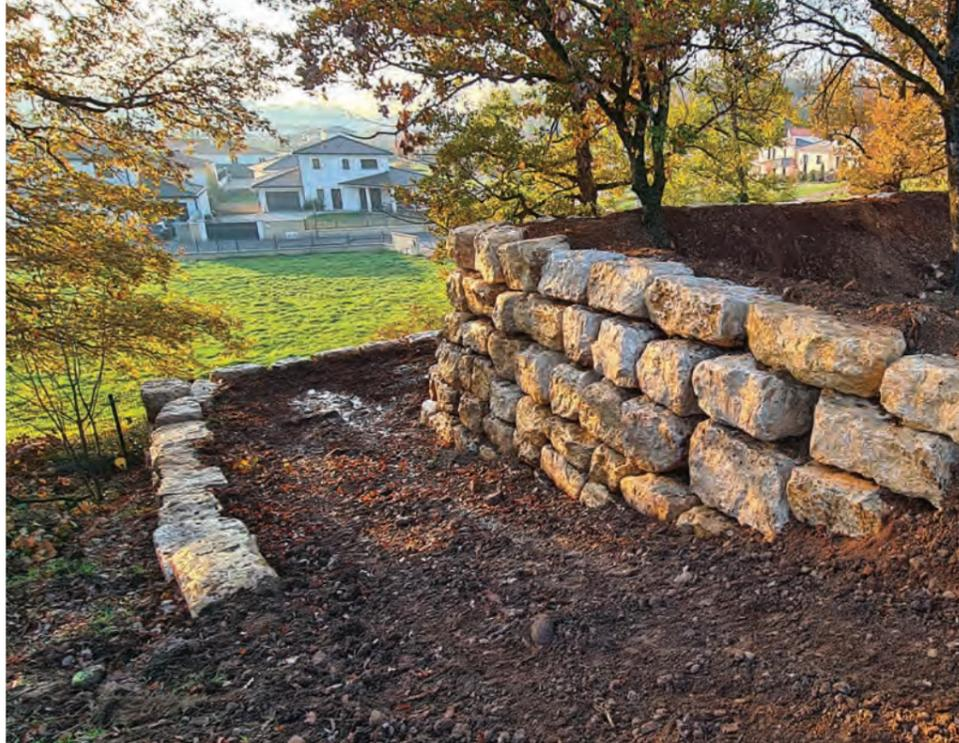
Enrochement calibré 600 – 800 kg de type calcaire
